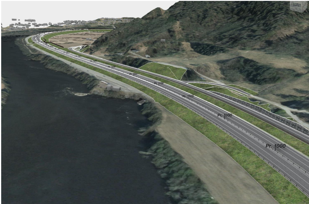
Figur 10 Gyllbekken bekkekulvert, sett mot nord (Kilde: Norconsult)
