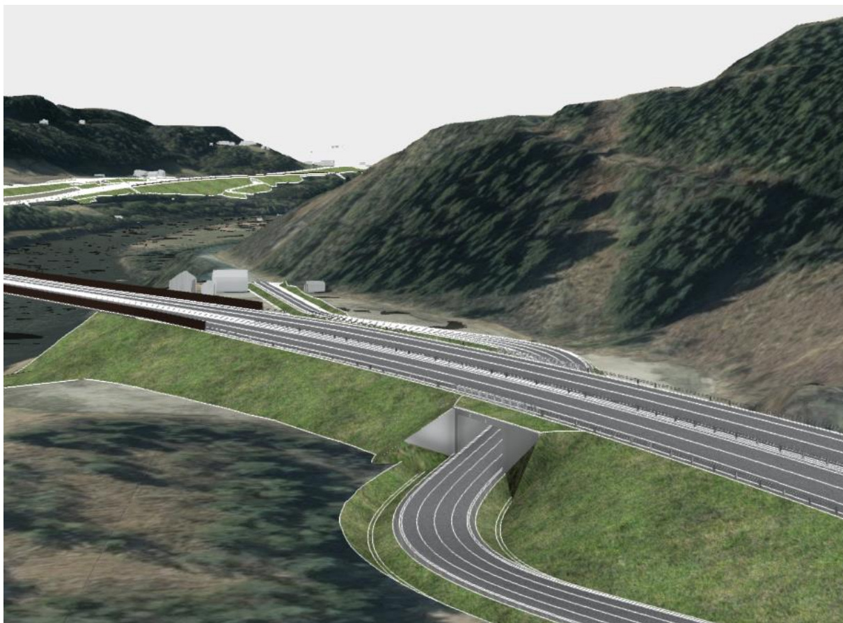
Figur 34 Sandbrauta kulvert med overliggende E6, sett mot sør (Kilde: Norconsult)
