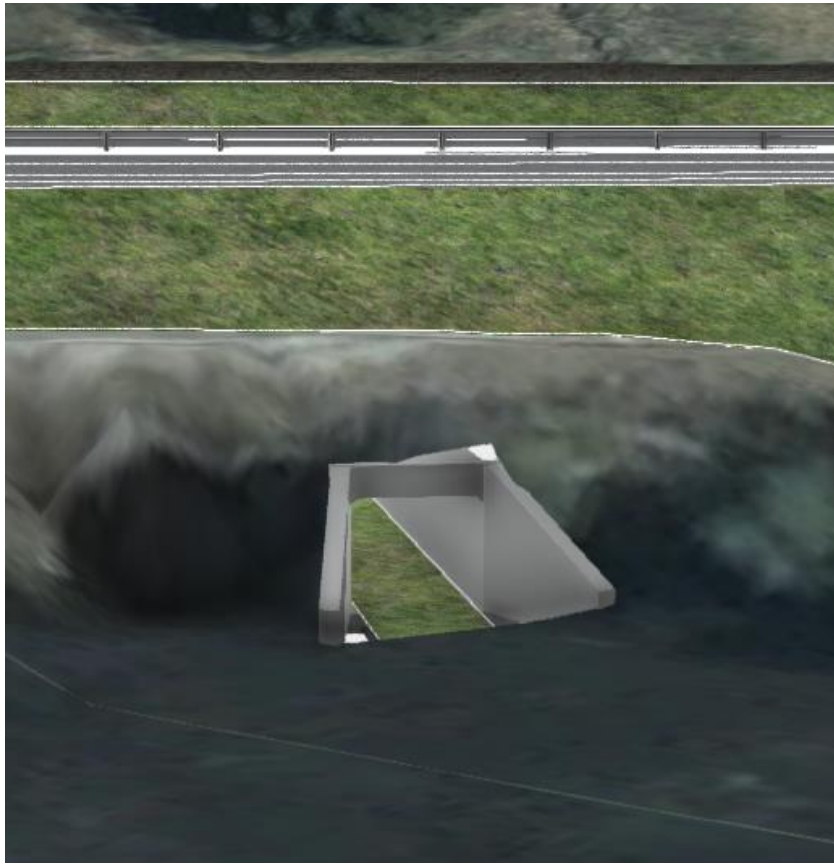
Figur 8 Gyllbekken bekkekulvert, sett mot vest (Kilde: Norconsult)
