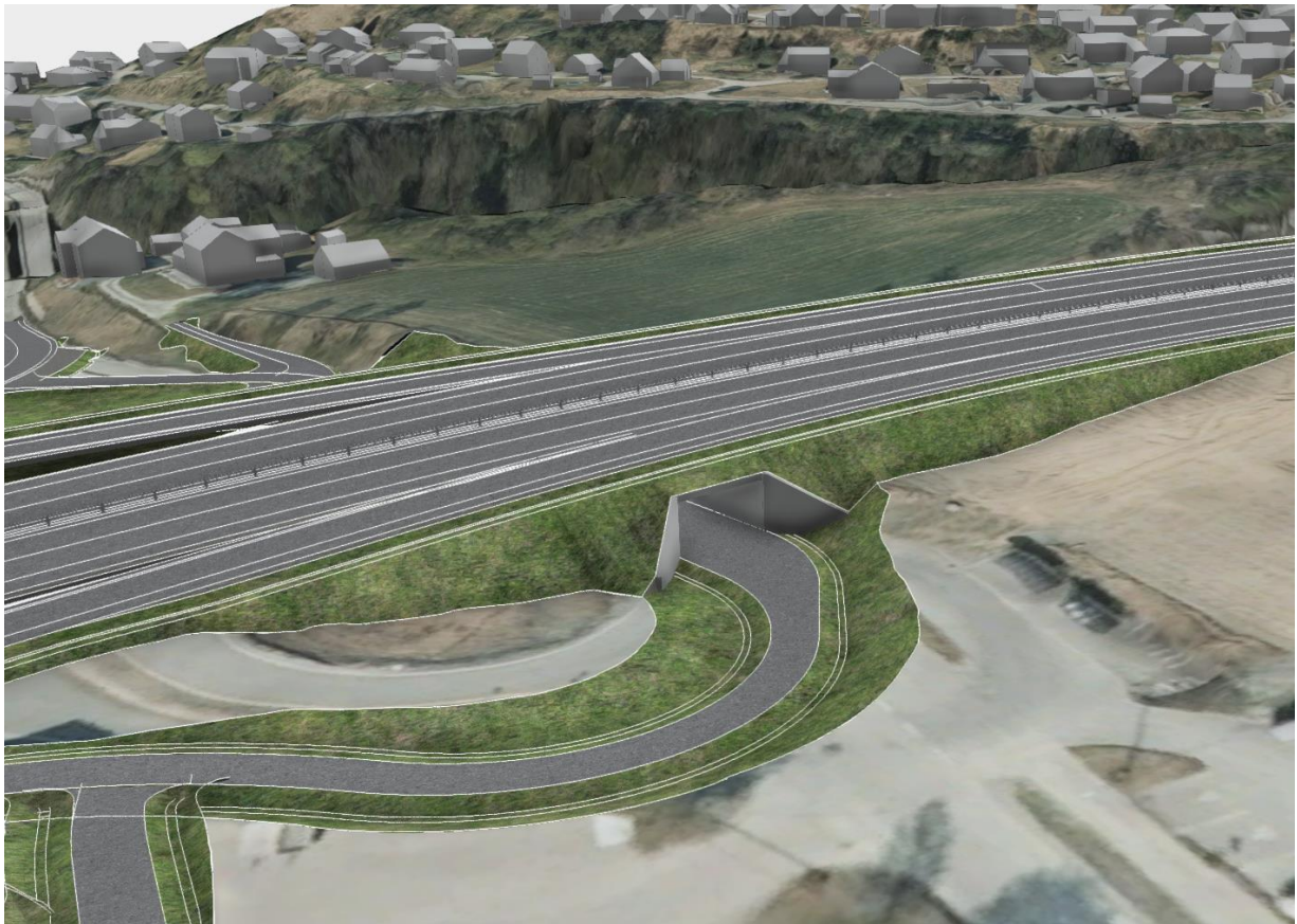
Figur 21 Fosskrysset kulvert med overliggende E6, sett mot nordvest (Kilde: Norconsult)
