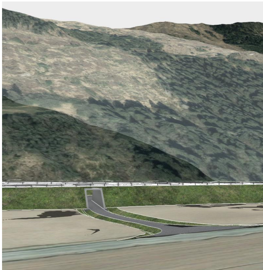
Figur 40 Evjengrenda kulvert, sett i retning nordvest (Kilde: Norconsult.)
