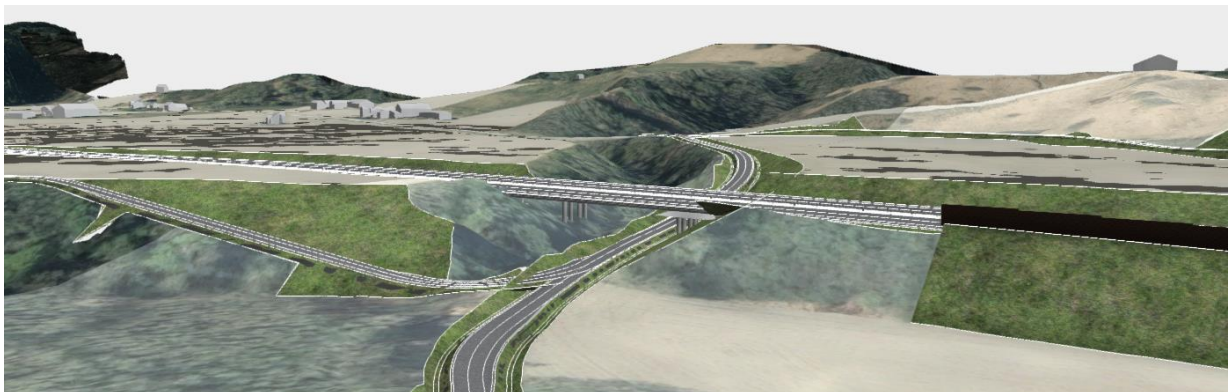
Figur 51 Eidsmobrua sett mot sørvest (Kilde: Norconsult.)
