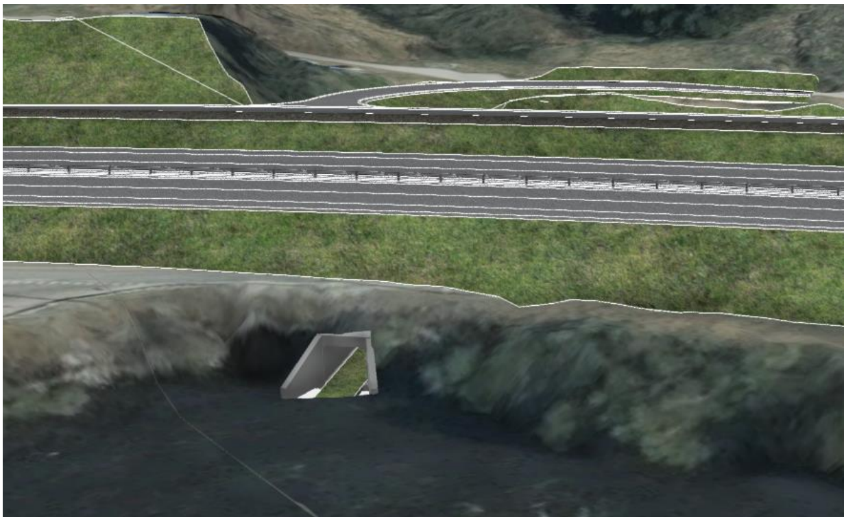
Figur 7 Gyllbekken bekkekulvert, sett mot øst (Kilde: Norconsult)
