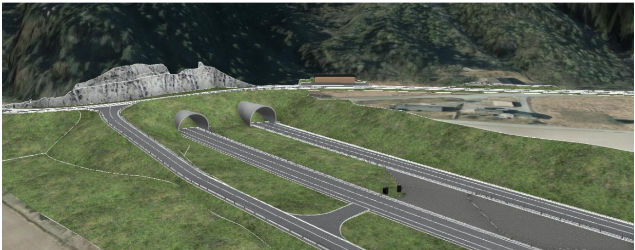
Figur 46 Homyrkamtunnelen portal nord, sett mot sørvest (Kilde: Norconsult.)
