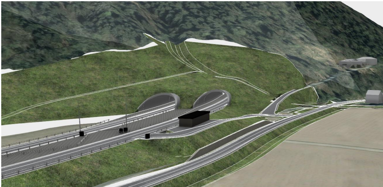
Figur 43 Homyrkamtunnelen portal sør, sett mot nordvest (Kilde: Norconsult)
